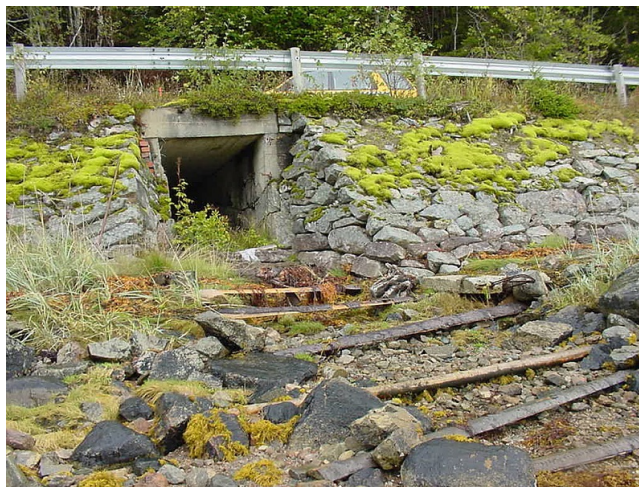
Stikkrenne. Foto: Per Gevik
